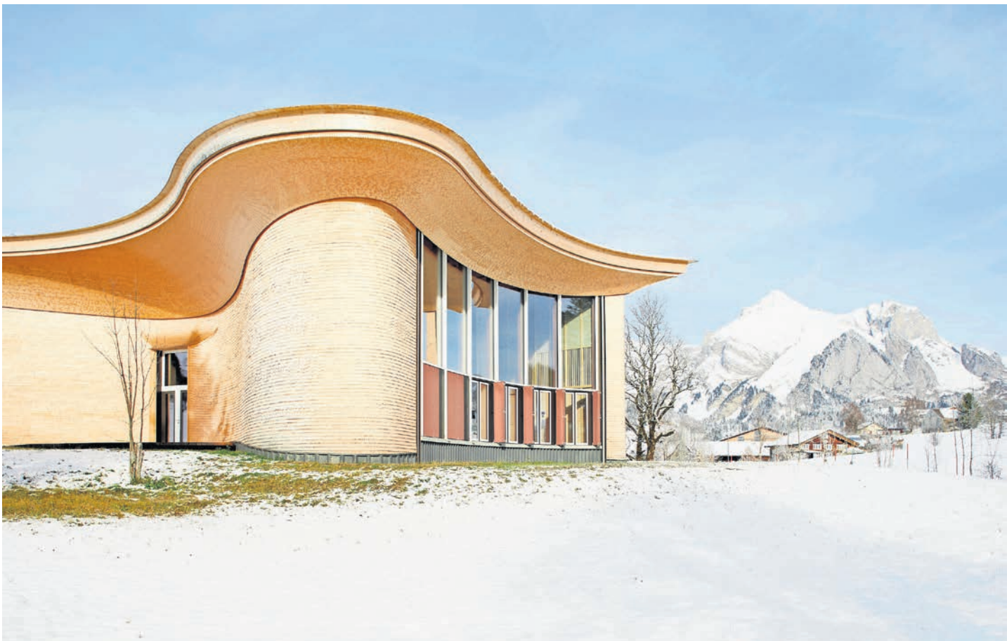
Das Klanghaus mit seinem beeindruckenden Zentralraum (Foto S. 17 oben).
