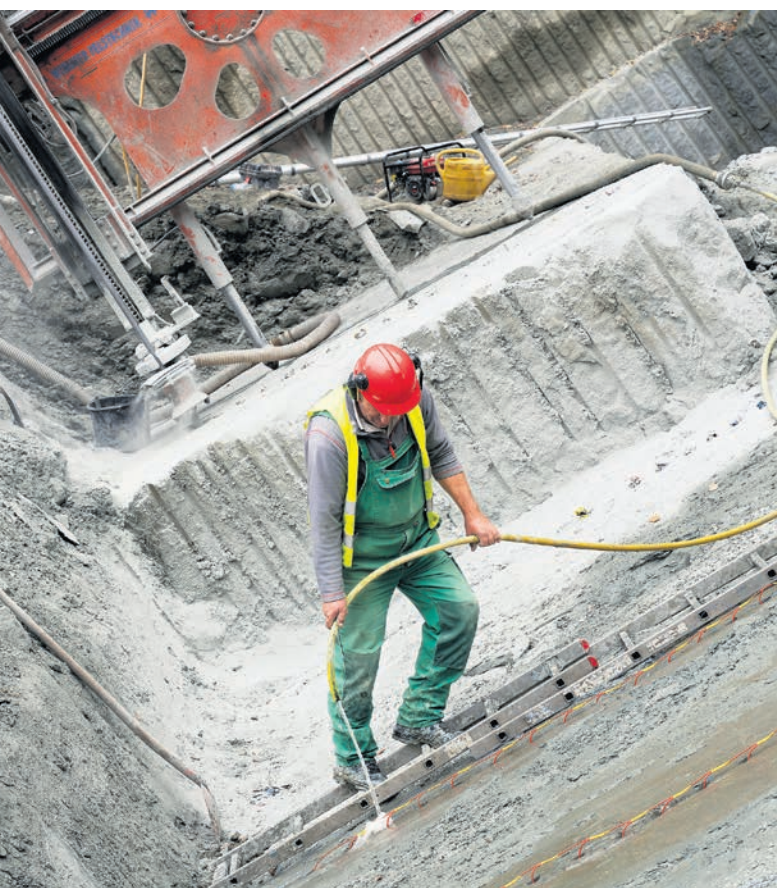
Les cordons de détonation jaunes se placent dans les trous de forage et sont reliés entre eux. Il faut ensuite remplir d'eau les trous de forage afin de renforcer l'effet de la détonation.
