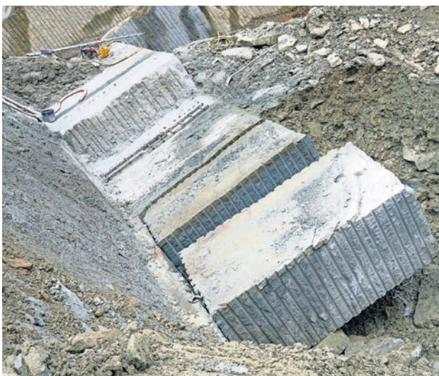
Une détonation parfaite: deux blocs de plusieurs tonnes sont prêts à être travaillés par la maison Emilio Stecher AG à Root.
