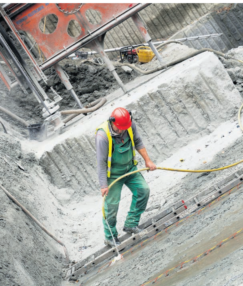
Die gelben Sprengschnüre sind in die Bohrlöcher eingeführt und miteinander verbunden worden. Anschliessend werden die Löcher mit Wasser gefüllt, um die Sprengwirkung zu verstärken.
