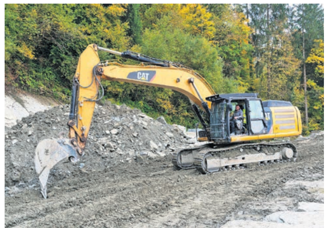
Mit schwerem Gerät werden die Blöcke geborgen.
