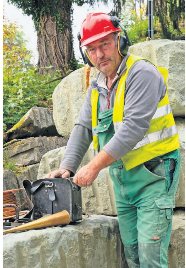
Über die Zündanlage wird die Sprengung ausgelöst.
