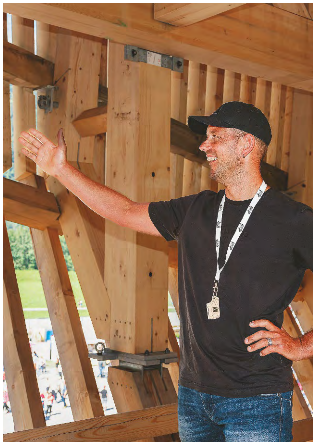
1200 Kubikmeter Schweizer Holz wurden verbaut.
