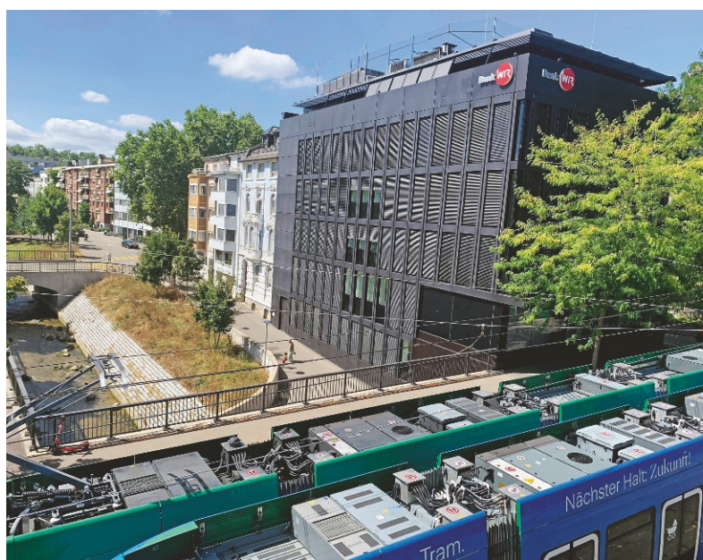
Voici comment se présente aujourd'hui le siège social de la Banque WIR, sur la rive de la rivière Birsig, qui coule désormais à nouveau à ciel ouvert.
