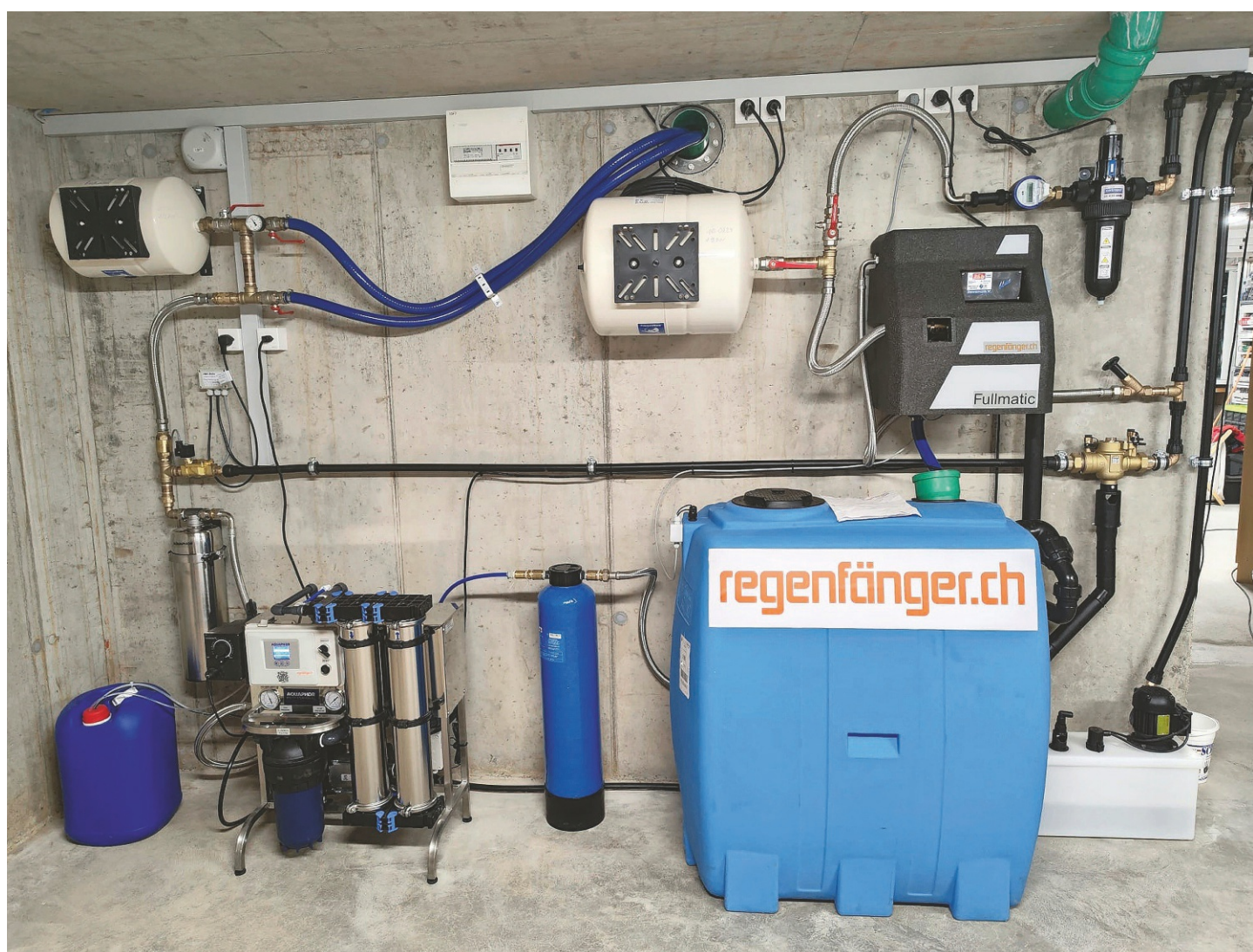
Une installation de traitement de l'eau Apro 150-750, qui transforme l'eau de pluie en eau potable.
