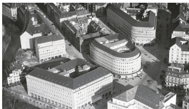
Seit über 90 Jahren bildet der Handelshof (oben rechts) zusammen mit dem Schmidhof (Mitte) und der Sihlporte (unten links) eine imposante Einheit.
