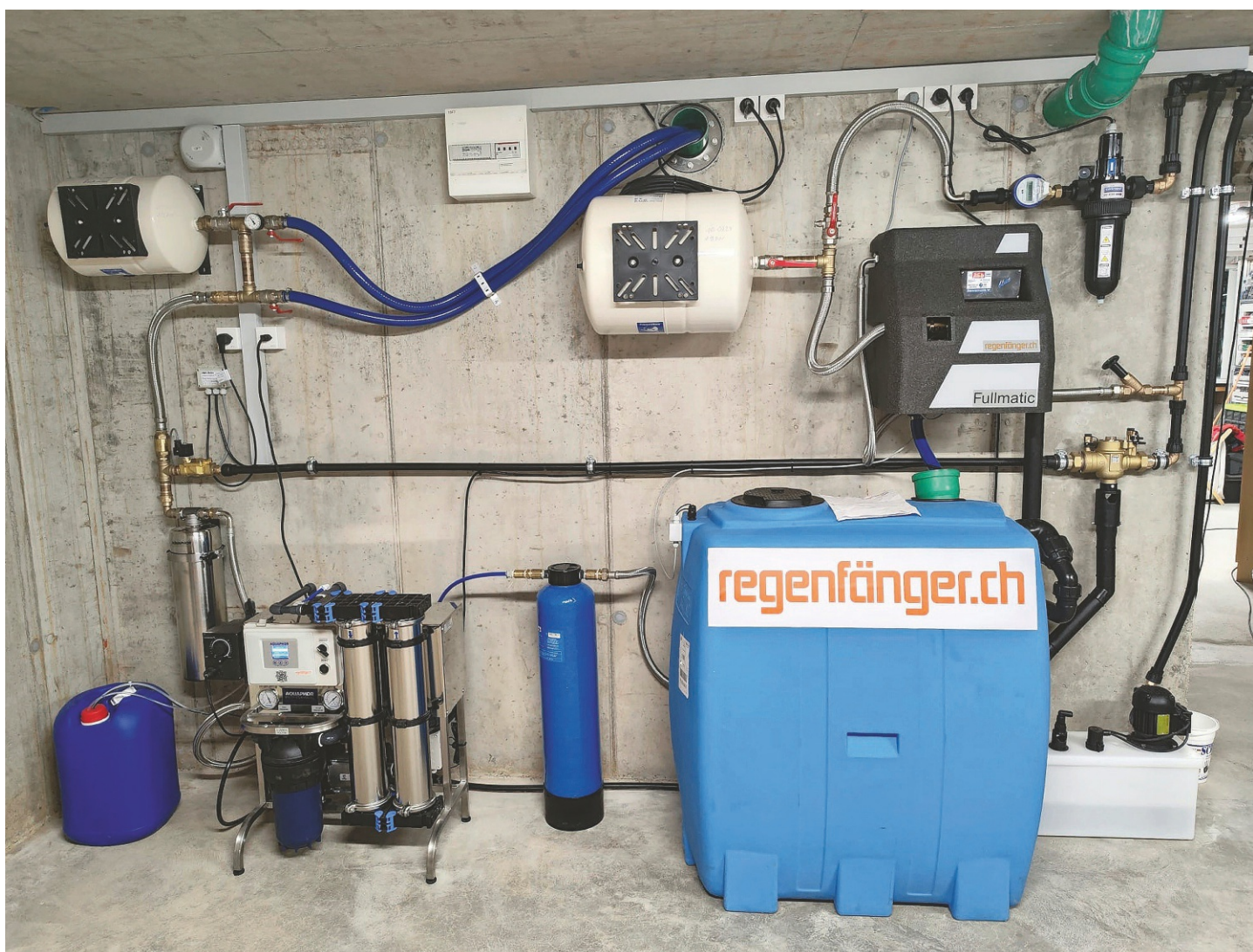
Eine in die Haustechnik integrierte Aufbereitungsanlage Apro 150-750, die Regenwasser zu Trinkwasser macht.
