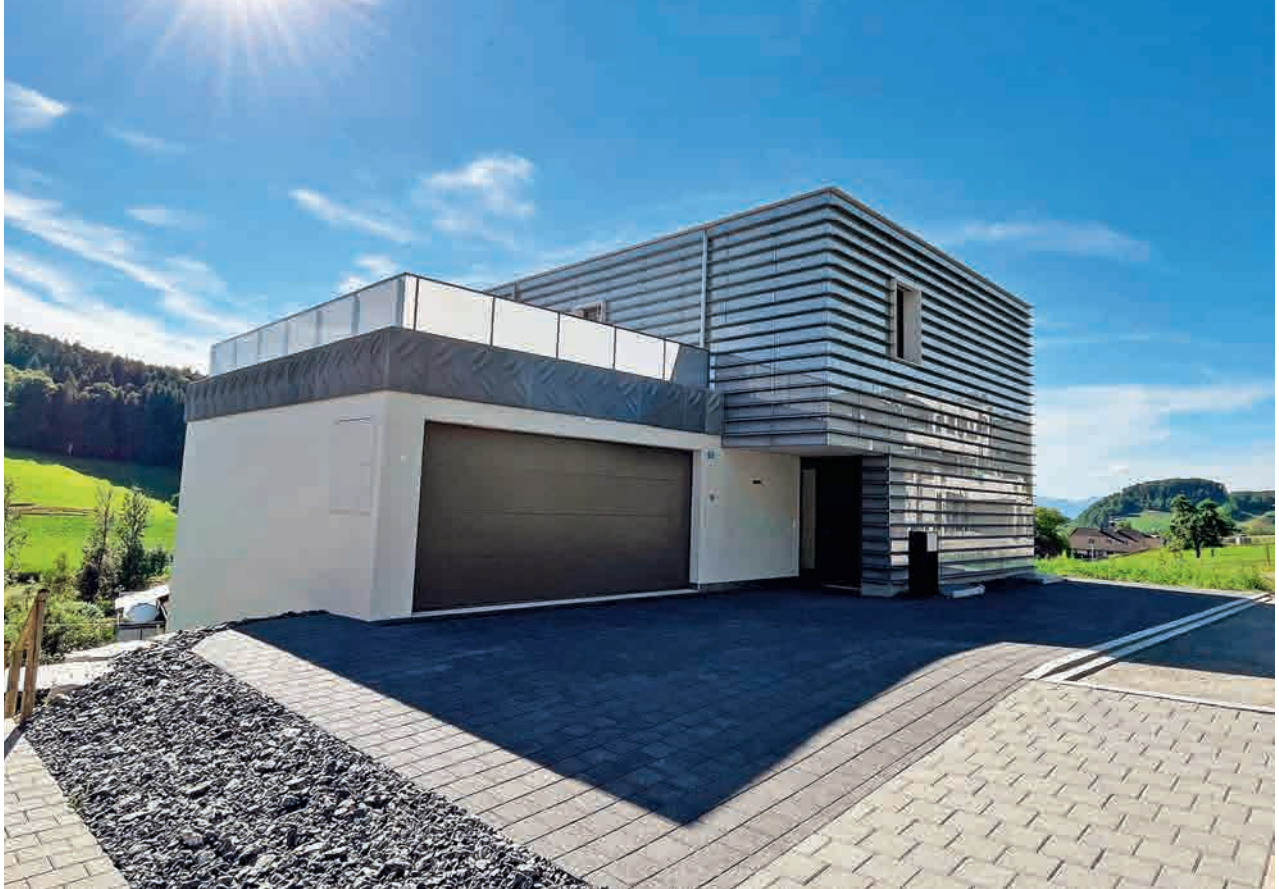
Eine weitere, patentierte Eigenentwicklung: Die TWD-Fassade heizt bzw. kühlt Wohn- und Gewerbebauten.
