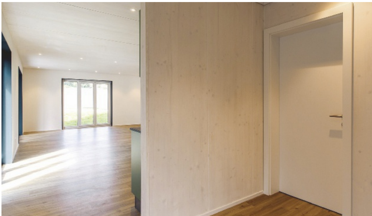
Die ECOCELL-Bauelemente sind Leichtbau-Verbundwerkstoffe aus recyceltem Papier und Holz. Sie können schnell und einfach montiert bzw. demontiert und wiederverwendet werden.
