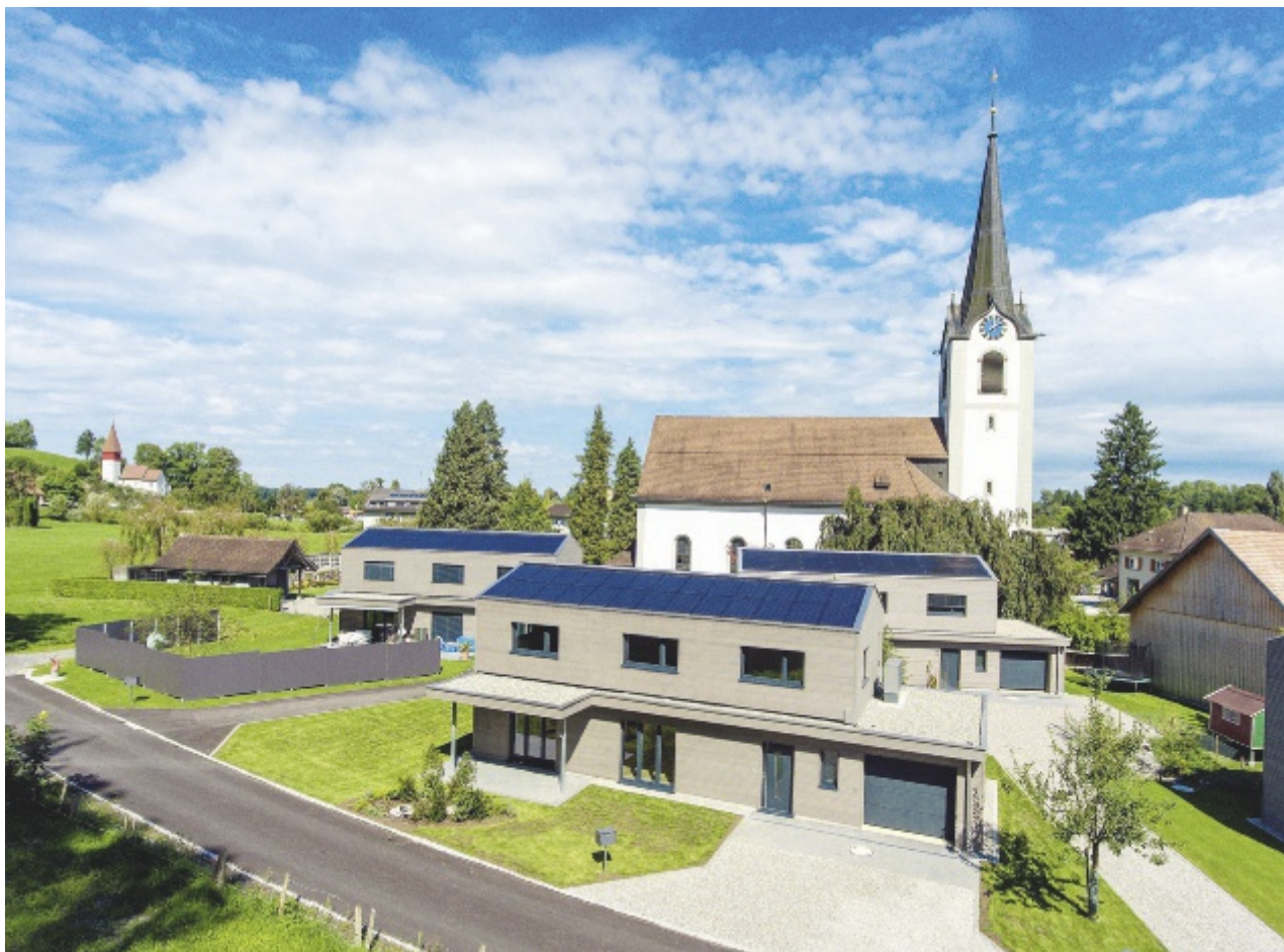
In Uttwil entstehen ECOCELL ECO-Solar-Häuser mit Solardach.
