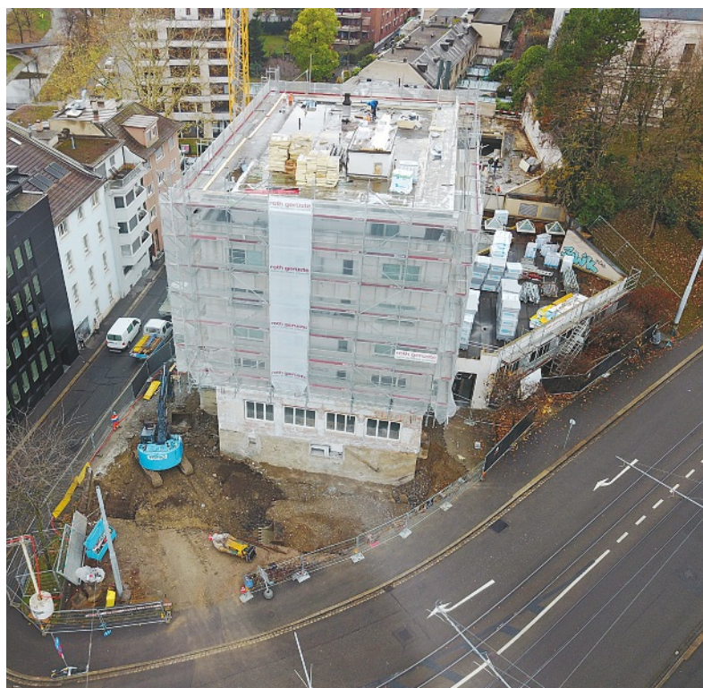
Beim Projekt «Auberg 3» in Basel für die WIR Bank wurde mit einem Stahlbeton-Korsett (siehe rote Pfeile) an der Fassade die geforderte Erdbebensicherheit nachträglich erfüllt.
