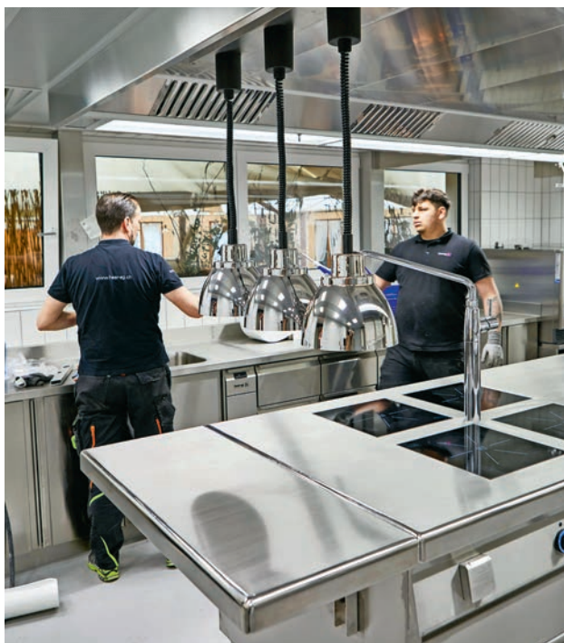
Mitarbeitende der Firma Heer AG Gastronomie-Einrichtungen beim Einbau der neuen Küche.
