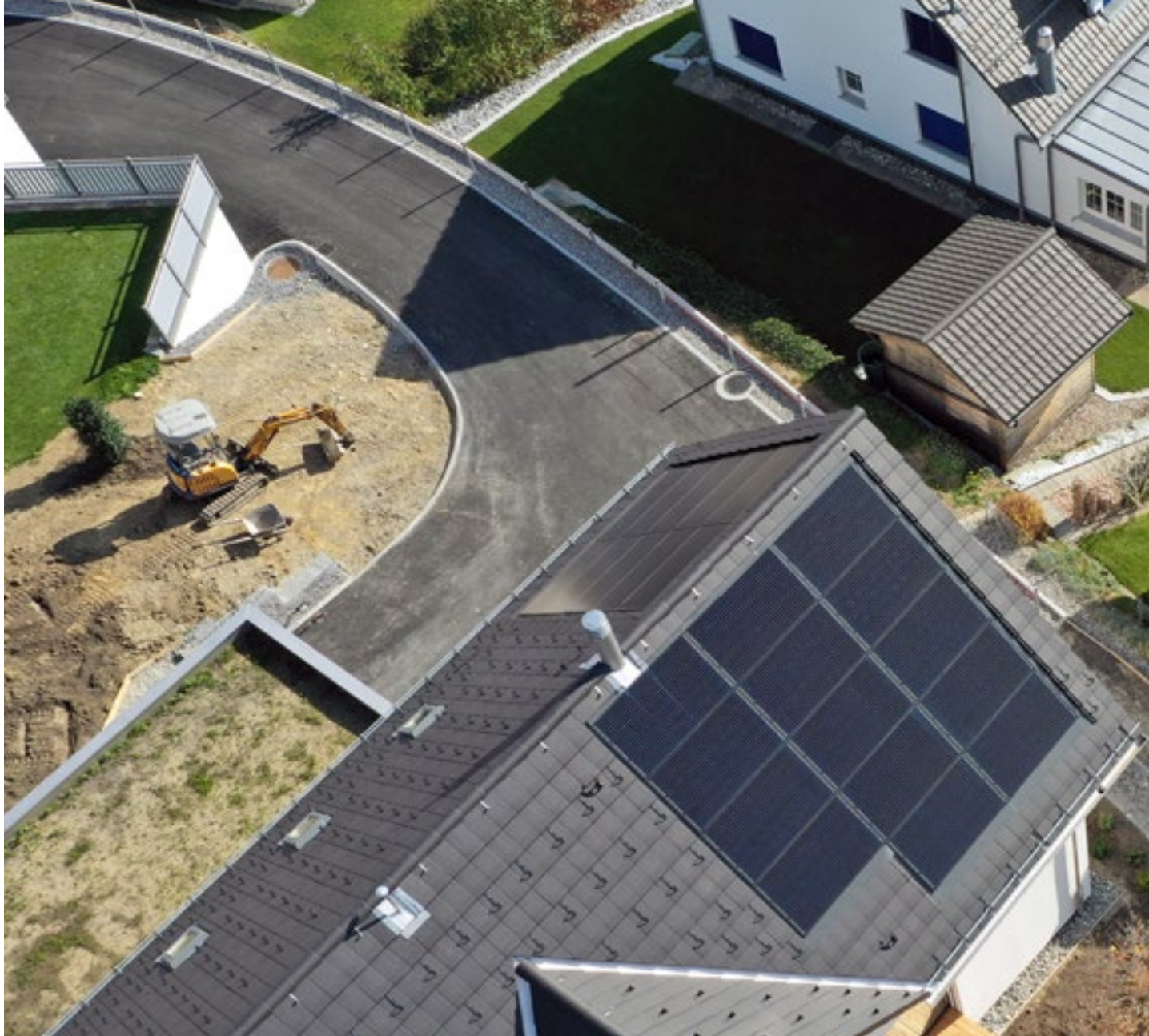
Exemples d'une installation incorporée à la toiture (à gauche) et d'une autre montée par-dessus la toiture (à droite).
