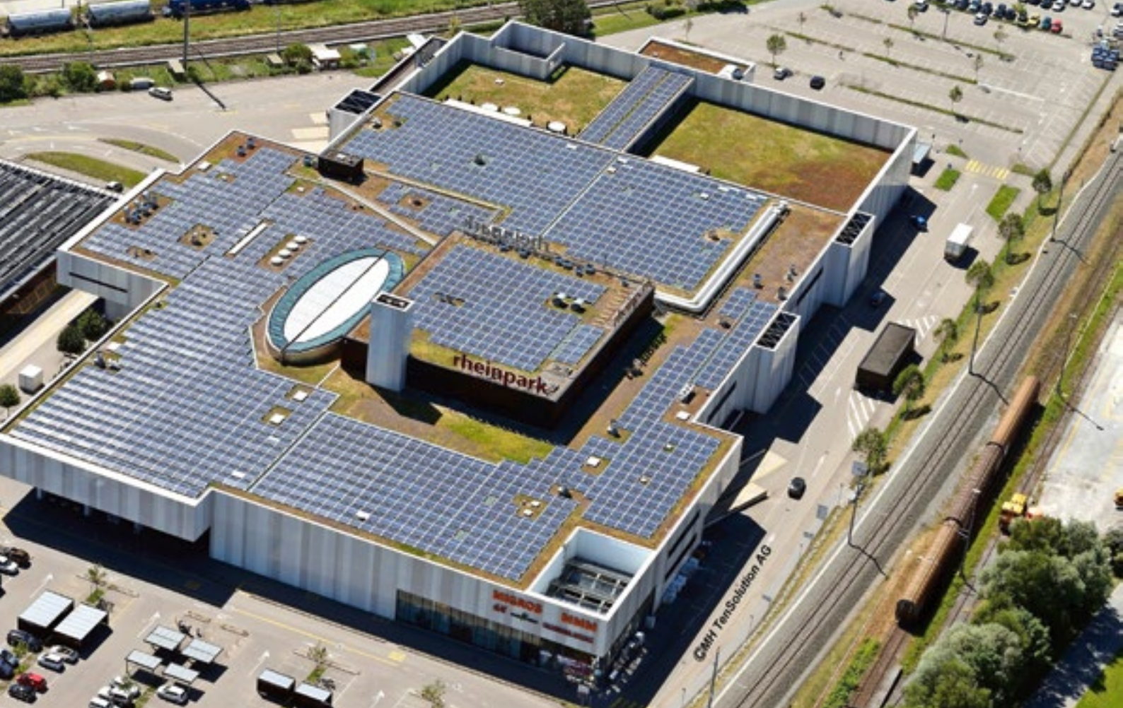
Le centre commercial Rheinpark à St. Margrethen atteint 918,32 kWp.
