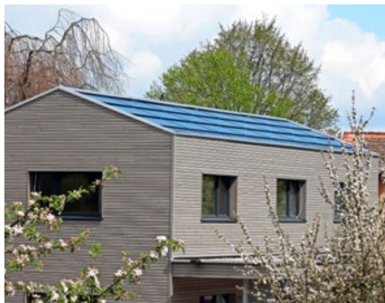
Idéale pour les nouvelles constructions: une installation photovoltaïque incorporée au toit.
