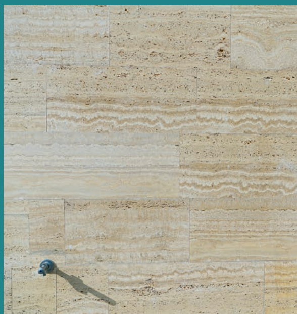
Vue détaillée: les plaques de travertin sont posées sans joints.
