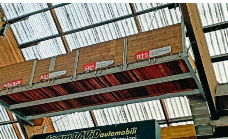
Schwindelfreiheit erforderlich: die Kameratribüne unter dem Dach.
