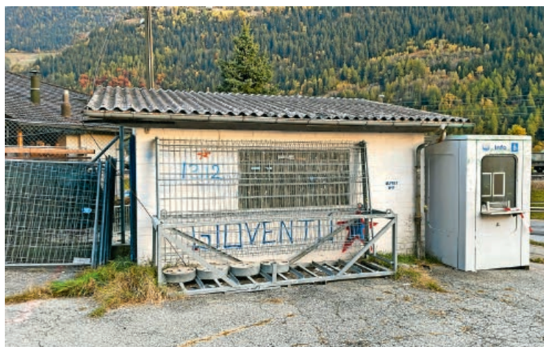
... der «Pista la Valascia» die Bagger auffahren. Fotos: Volker Strohm
